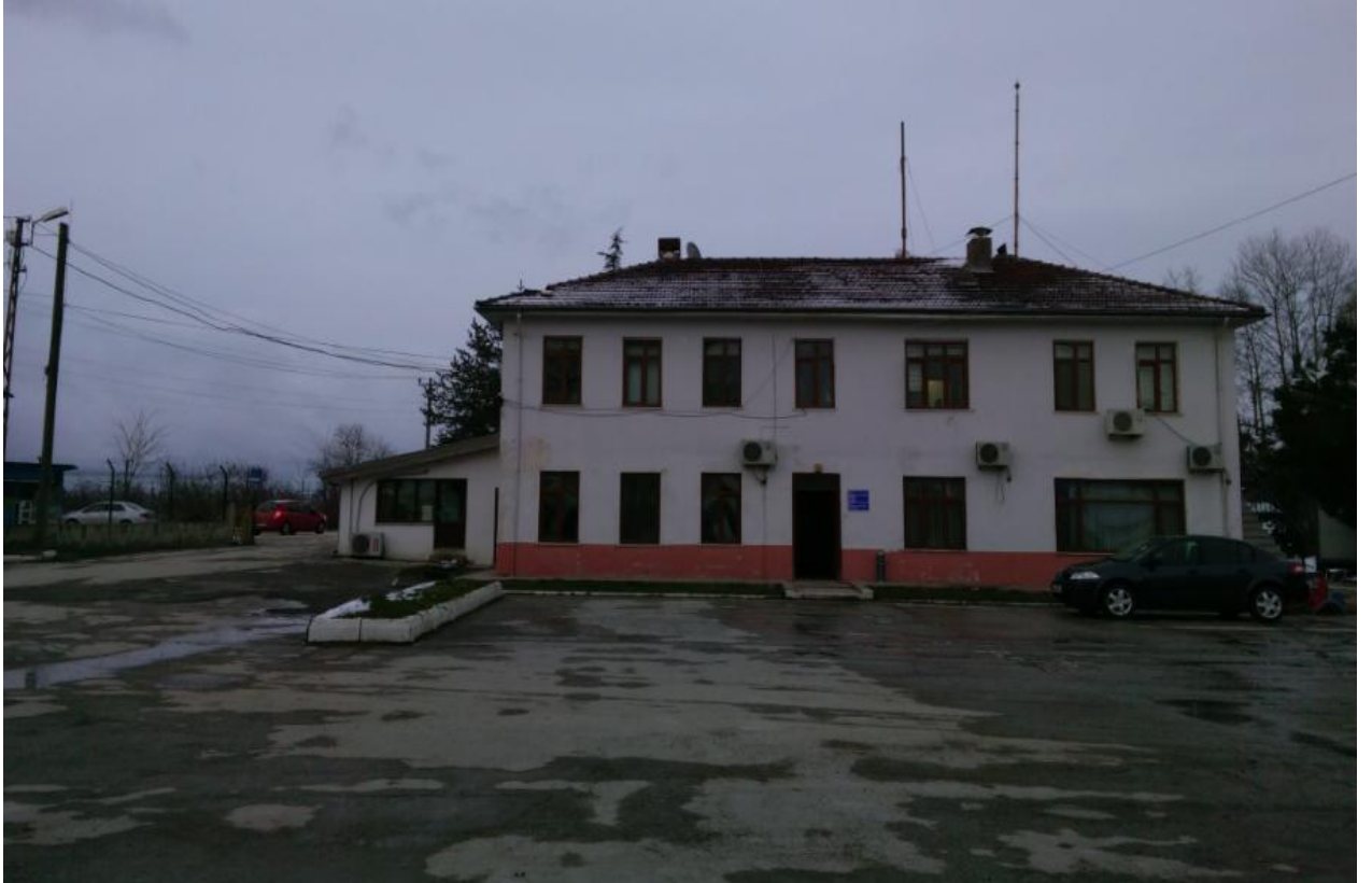
Eski Köy Hizmetleri Binası
